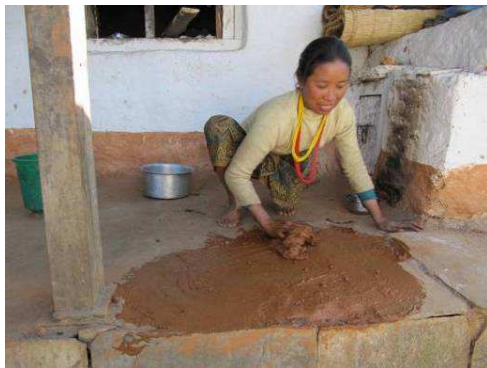
Passage de l'enduit terre bouse de vache.
