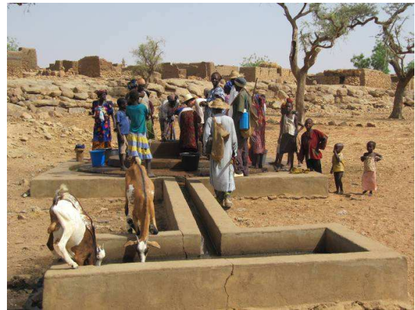
Puits en béton avec bac de récupération
