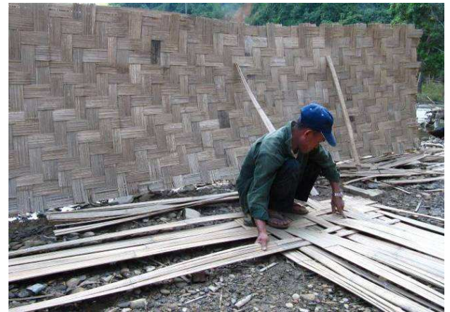
Construction d'un mur en bambou tressé
