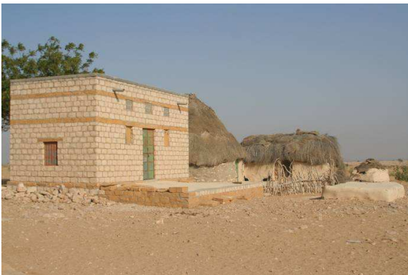
Une maison en pierres et ciment.
