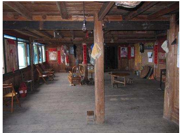
Pièce principale du 1 er étage.
